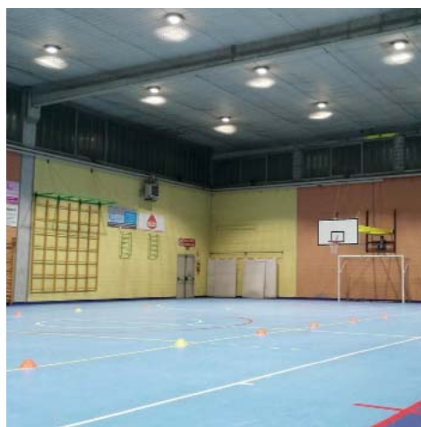
Sopra: La nuova illuminazione della palestra della scuola elementare
